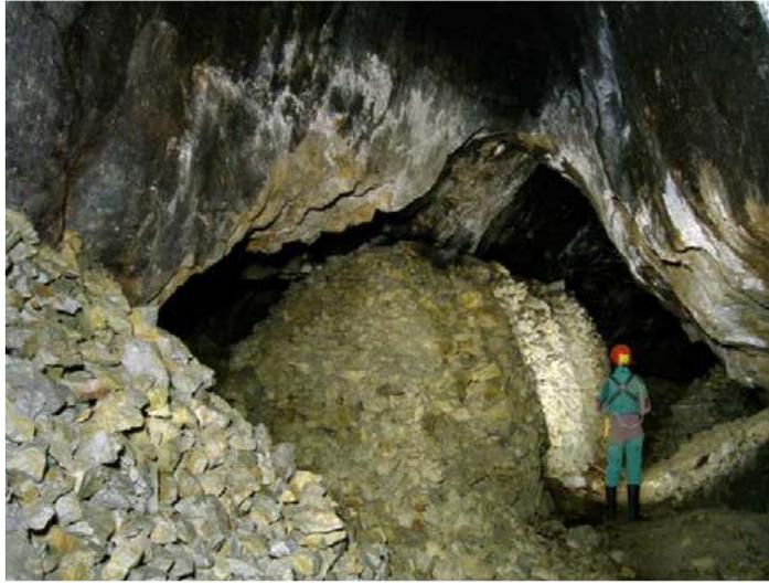
**Figure 1 Exploration de la Mine médiévale, galerie creusée par la technique d'abattage par le feu**
