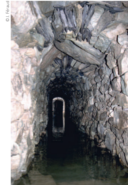
Vallauria : galerie d'exhaure Carlo Emanuele percée en 1784 et ici muraillée.
